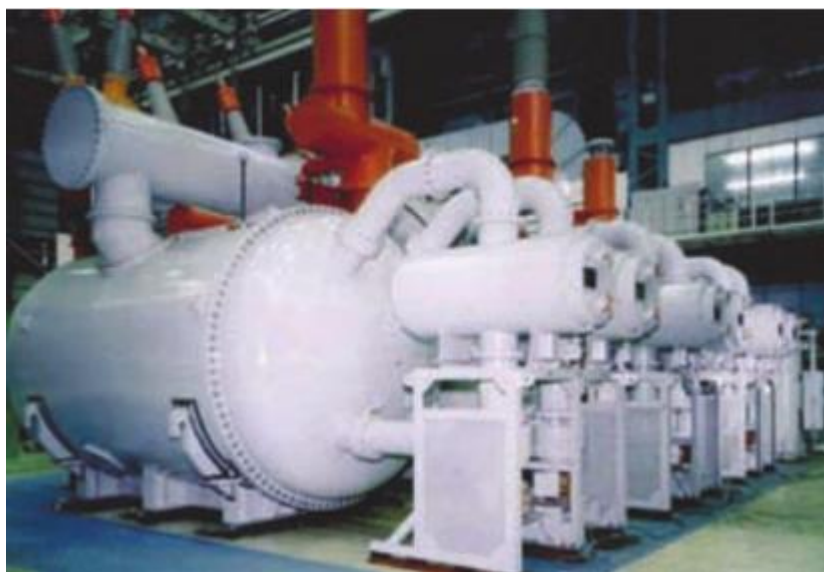
Рис.2. Элегазовый силовой трансформатор.
