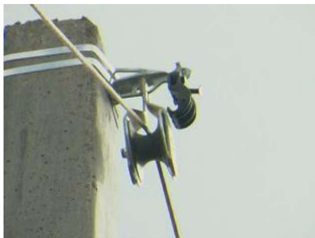
Рис. 3. Раскатывание каната – лидера и провода по роликам.
